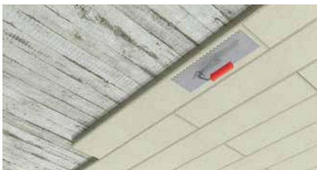
3. PAROC CGL 20cy plokštės prispaudimas.
